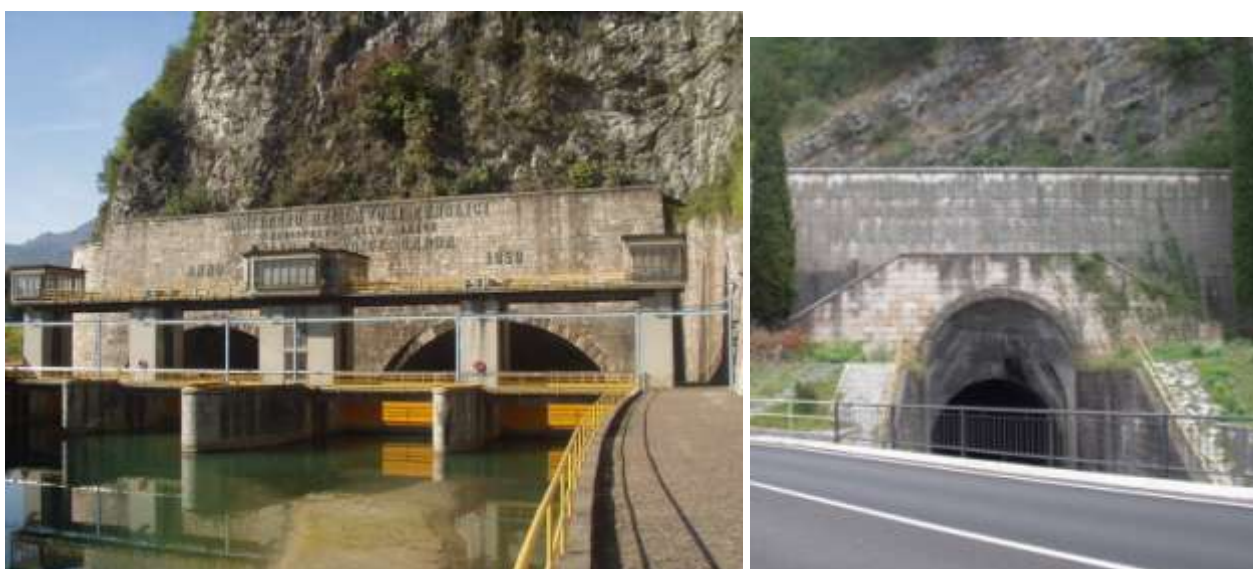
Figura 15 – L'imbocco (a sx) e lo sbocco (a dx) della Galleria Adige – Garda
