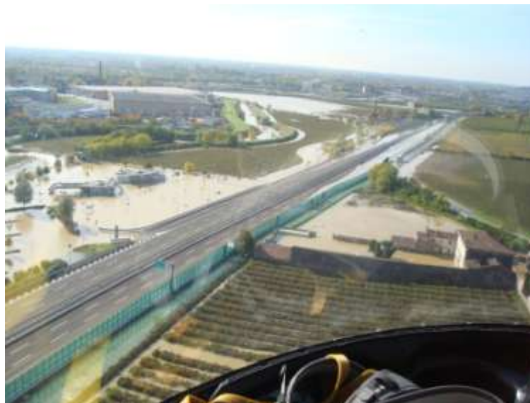
Figura 16 – Esiti della rotta del torrente Alpone a Monteforte (VR) (2010)
